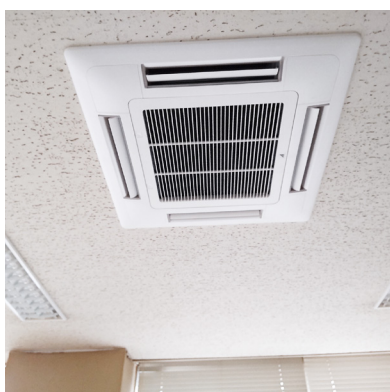
子育て施設の空調取替
